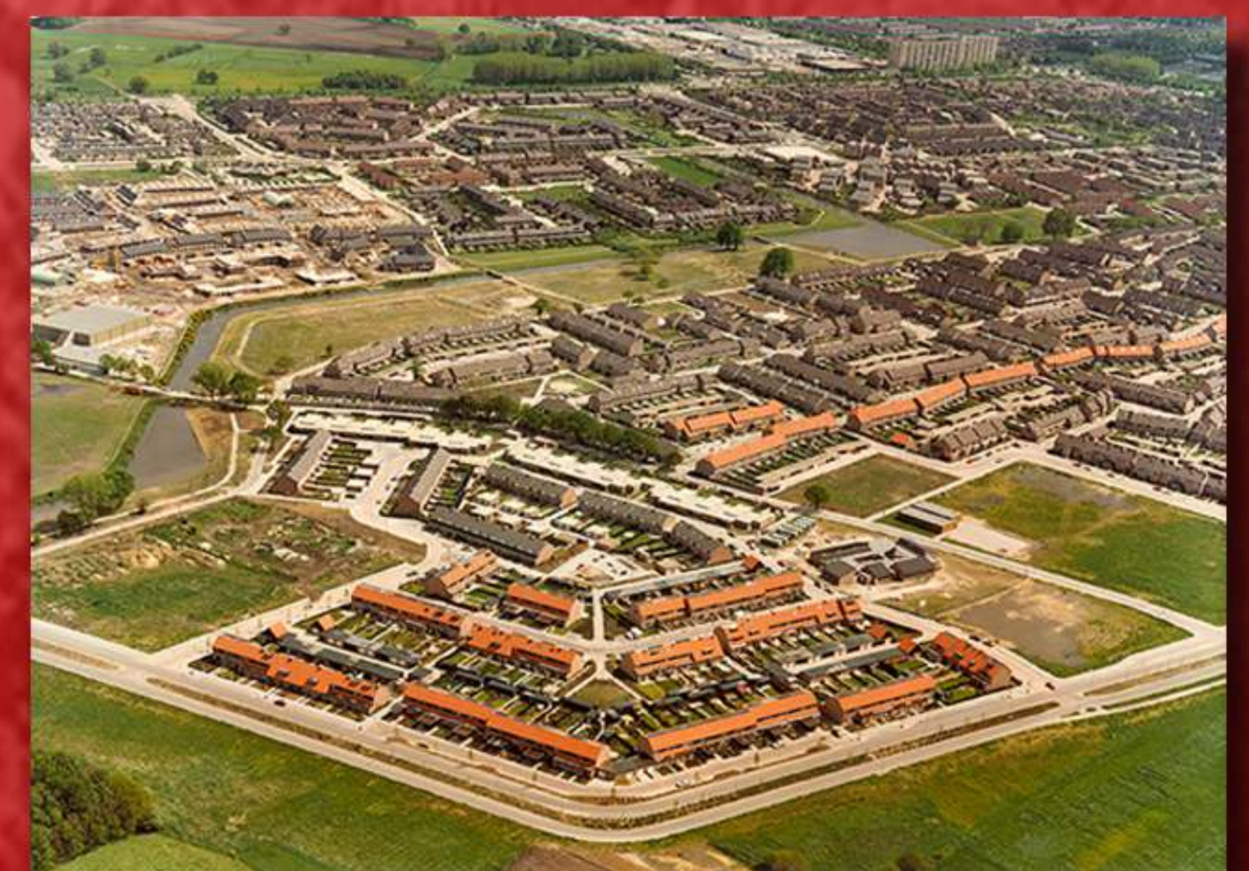
Aanleg van de Achtse Barrier in 1983
